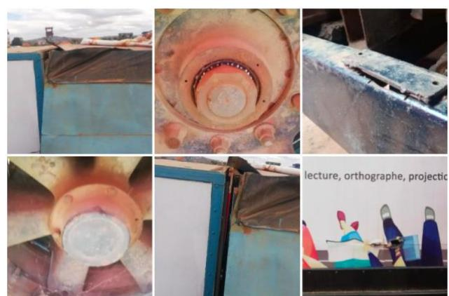
Parmi les réparations il s'agit notamment de remettre en l'état un cache roulement, quelques soudures et le retapage des tôles au niveau du toit et de la façade arrière.
